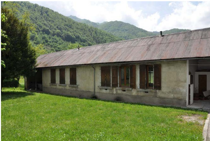
L'école avant sa rénovation
