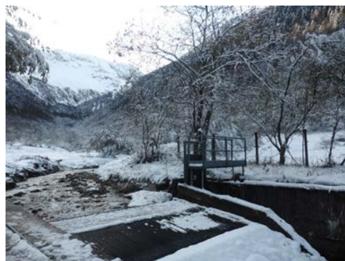
Prise d'eau du Garbet
