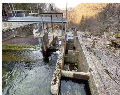
Photo depuis l'amont avant travaux (vanne de décharge étroite et passe à poissons)
