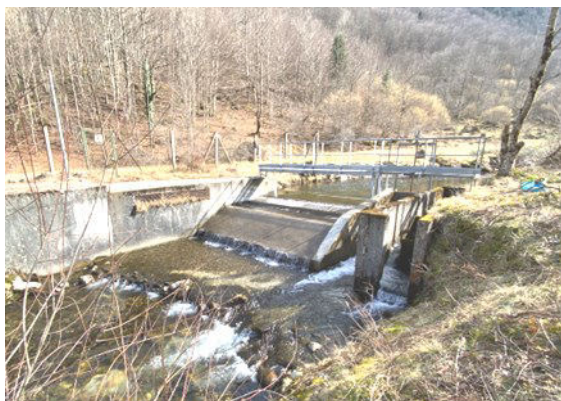
Photo depuis l'aval avant travaux
